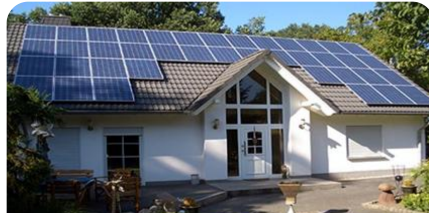
Symmetrische Modulanordnung um Spitzgaube, 8kWh
