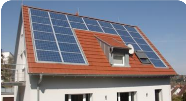
Indachanlage SOLRIF® auf Eigenheim, 5,88kWh
