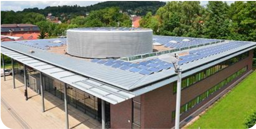
Fachhochschule Schmalkalden, SLZ 3, 260kWp
