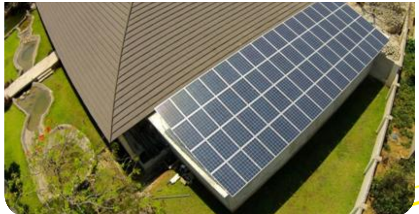
Aufständerung Foot Lover's Market in Tansania, 14,7kwp
