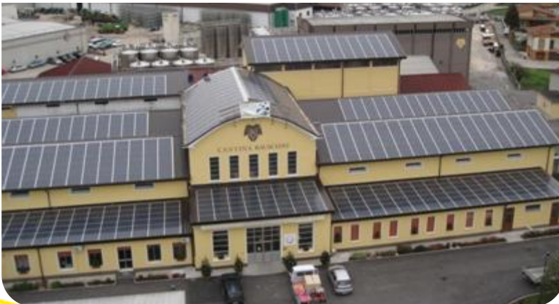
Indachanlage auf Weinkellerei Cantina Rauscedo, 199,71 kWp
